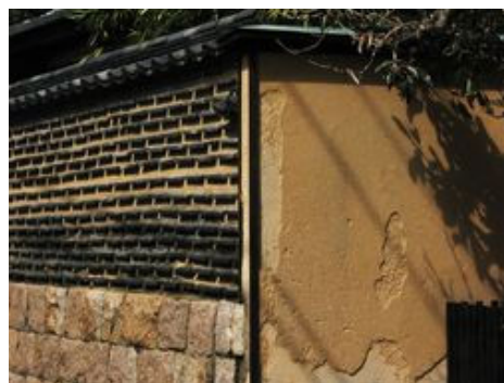
瓦をすきこんだ土塀
